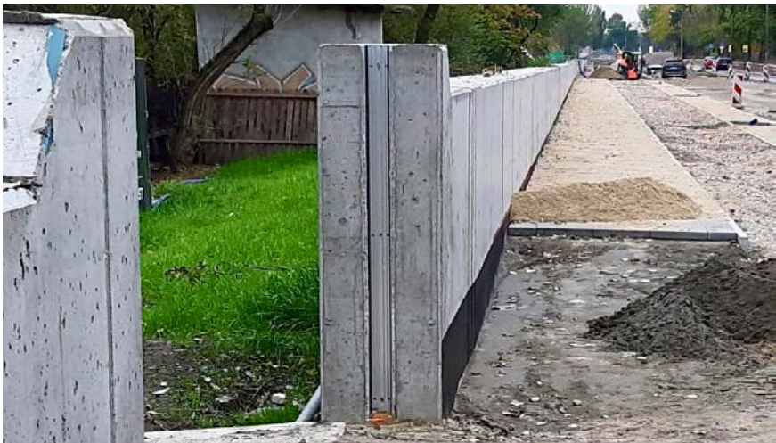
📍 Warsaw, Wybrzeże Helskie 📄 Mobile flood barriers in Warsaw 📏 from 0,2 to 1,8 m
