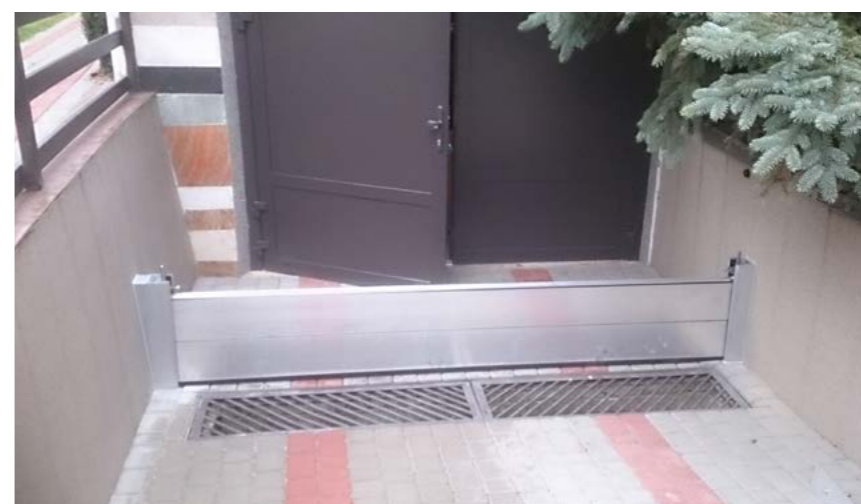
📍 Stasiopole 📄 Zabezpieczenie wjazdu do garażu w miejsc. Stasiopole 📏 0,3 m
