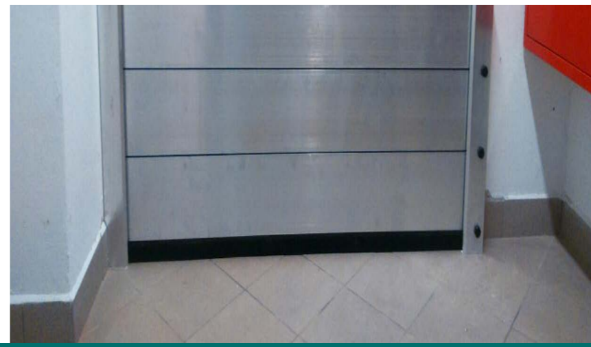
📍 Stalowa Wola 📄 Zabezpieczenie budynku sądu w Stalowej Woli przed gwałtownymi ulewami 📏 0,6 m
