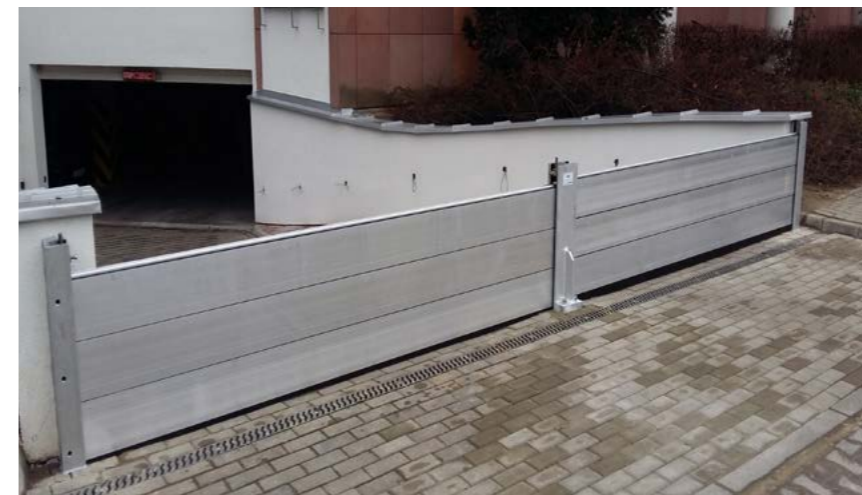
📍 Warszawa 📄 Zabezpieczenie przeciwpowodziowe budynków mieszkalnych 📏 0,4 i 0,6 m
