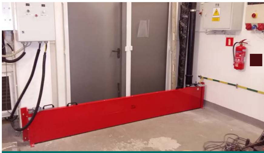
📍 Łódź 📄 Zamontowanie szczelnych barier przemysłowych 📏 0,4 m
