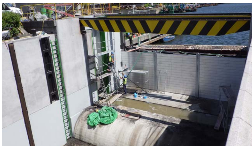
📍 Warszawa 📄 Przebudowa śluzy Żerań 📏 3,6 m
