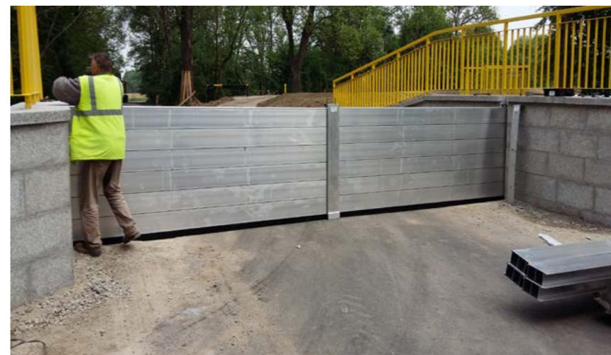
📍 Kotowice - Paniowice Modernizacja obwałowań w rejonie Widawy. Odcinek Kotowice - Paniowice, gm. Oborniki Śląskie 📏 1,2 m
