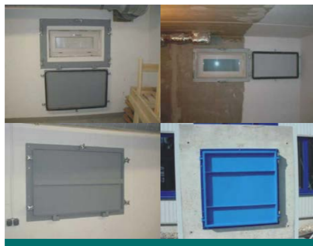
Zabezpieczenie przeciwpowodzione okien piwnicznych.
