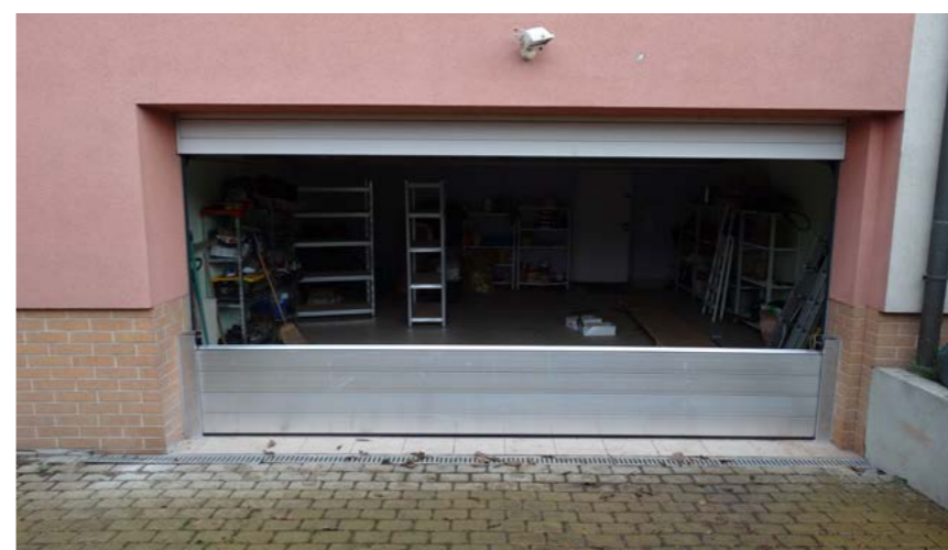
📍 Kraków Zabezpieczenie budynku mieszkalnego 📏 0,6 m
