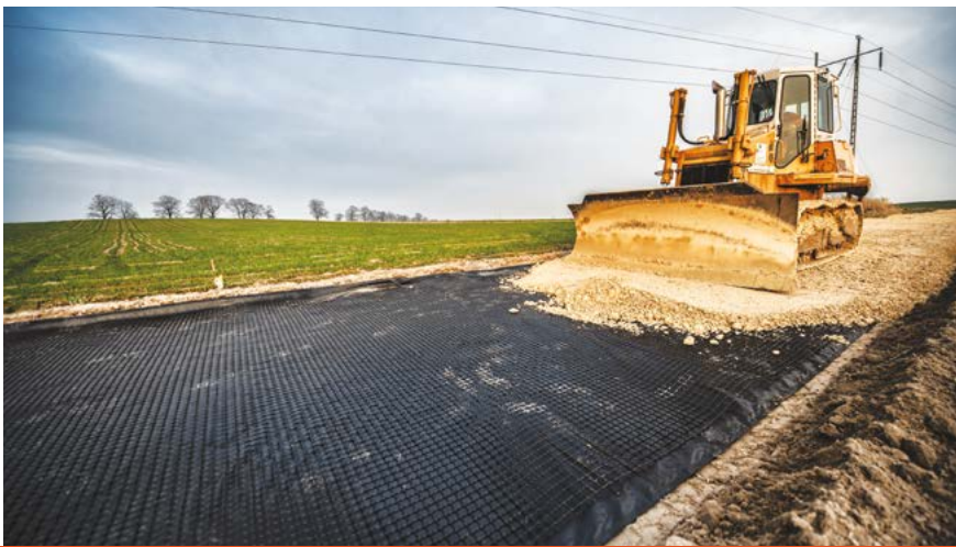
📍 Kępno (woj. wielkopolskie) 📄 Construction of a road to the wind farm 🔲 Polgrid BX 30/30 60.000 m 2
