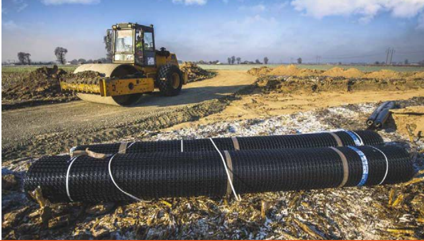
Inczew (woj. łódzkie) Budowa dróg technologicznych i dojazdowych do farmy wiatrowej, placów montażowych oraz platform roboczych Polgrid 30/30 180.000 m 2
