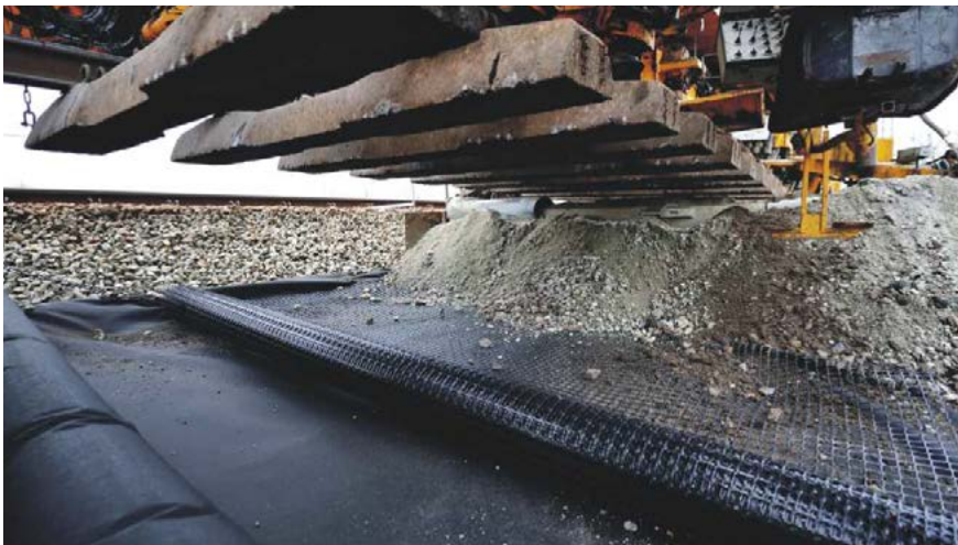
Brzezinka Średzka (woj. dolnośląskie) Zbrojenie warstwy ochronnej torowiska Polgrid BX 30/30 oraz geotkanina separacyjna 7.000 m 2
